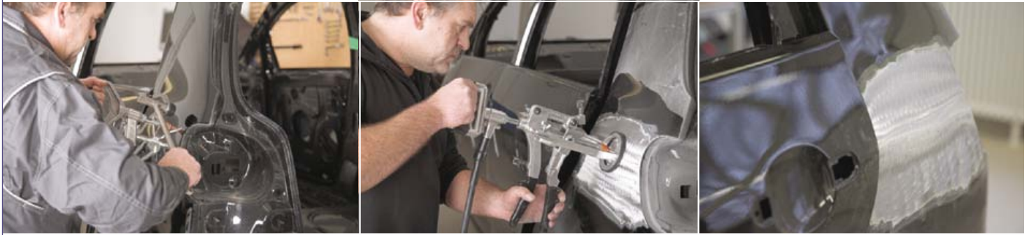
▲ Richt-Chronologie eines Golf V-Seitenwandschadens: Mit unterschiedlichen Zugwerkzeugen aus dem VAS 6321 läßt sich die Außenhaut und auch die Gürtellinienkante in den originalen Ursprungszustand wiederherstellen.
